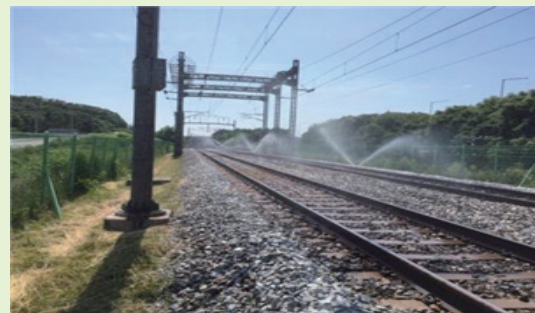
자동살수장치 시스템 운용 사진
